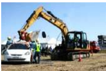
建設資機材を用いた車両移動作業訓練の様子 〔「高知県道路啓開手順書(案)」掲載/総務省資料より〕 (画像クリックで拡大表示)
